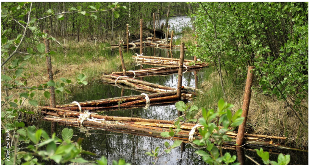
Kuva 2. Kuvia puurankanipuista. Huom! muodostelma poikkeaa asemapiirustuksesta esitetystä, kts. oikea asetelma asemapiirustuksesta. (Lähde: PuuMaVesi- hankkeen loppuraportti).
